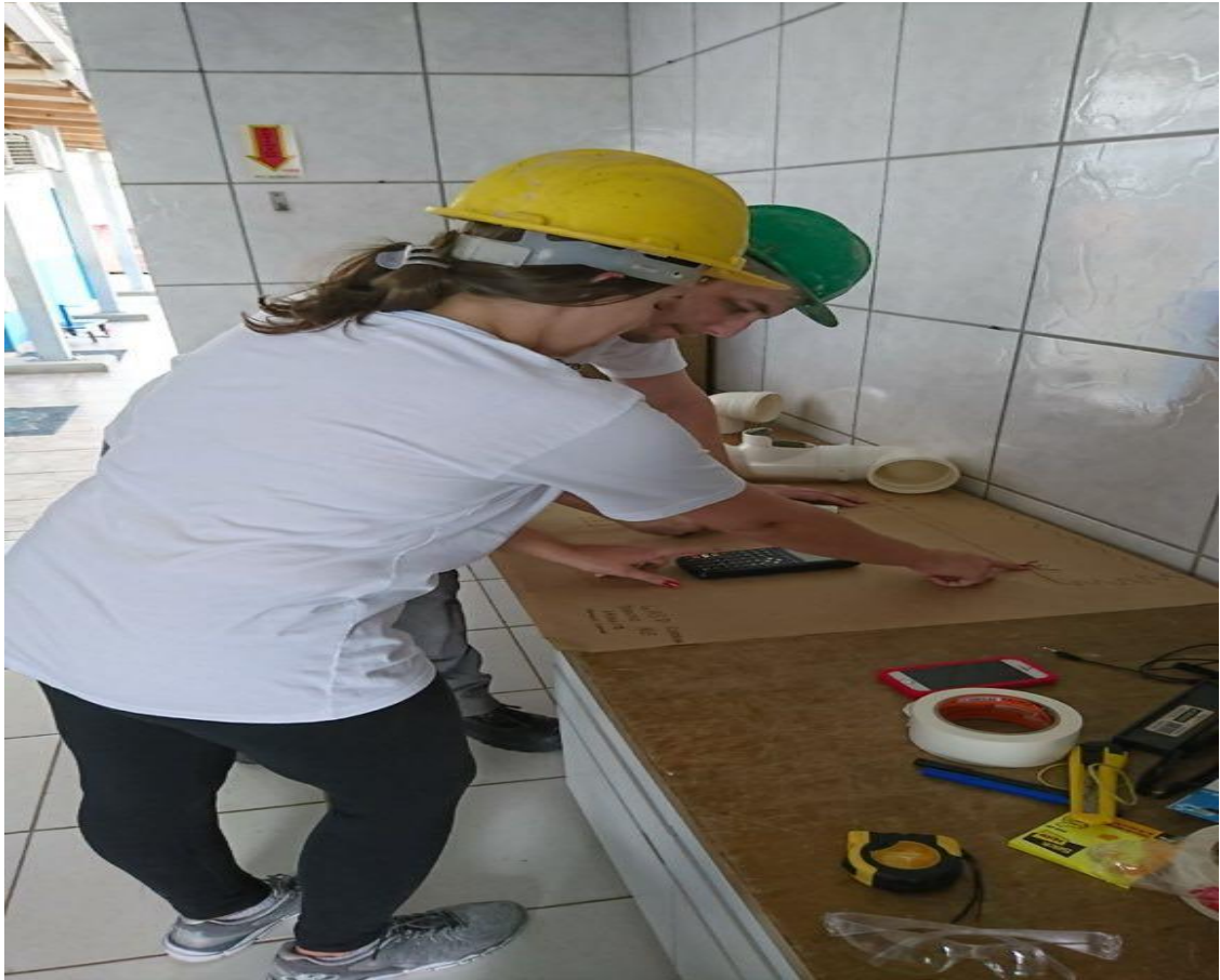
Figura 04: Preparação para montagem da Cisterna.
