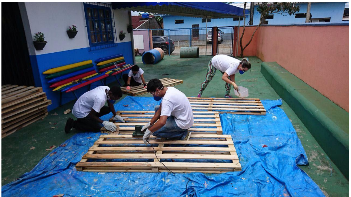
Figura 03: Preparação dos Pallets para base da Cisterna
