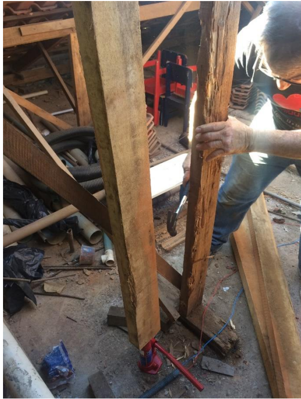
Figura 02: Troca madeiras comprometidas da cobertura
