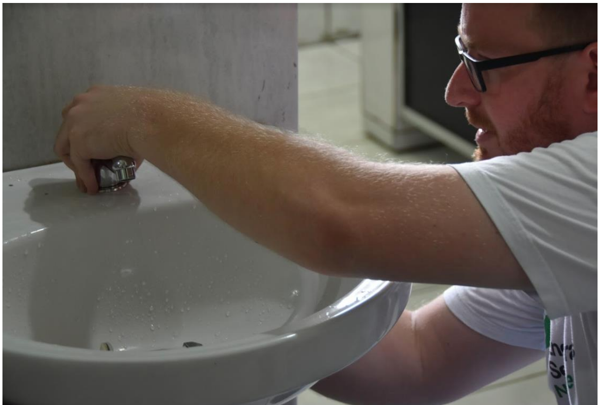
Figura 03: Troca de torneiras.
