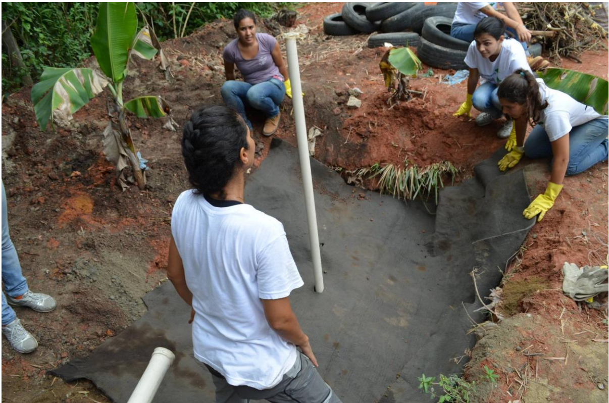
Ciclo de Cultivos - Tratamento das Águas Cinzas e 3ª ETAPA - Águas Marrons: Filtração, Infiltração e Evapotranspiração
